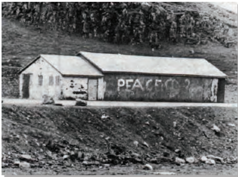
Félagsheimilið Neisti um 1980. Húsið var byggt árið 1924 og rífið árið 1987.
