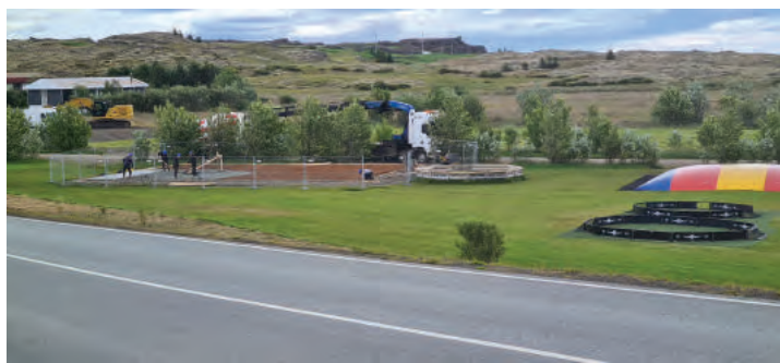
Steypuframkvæmdir í Blánni
