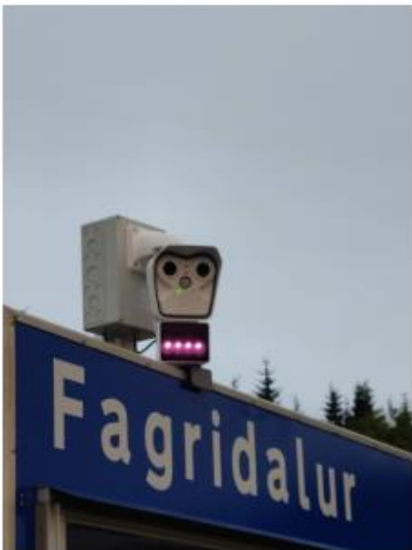
Mynd 4: Greiningarbúnaður festur á vindmælingarskilti. Staðsetning - Snið 3.
